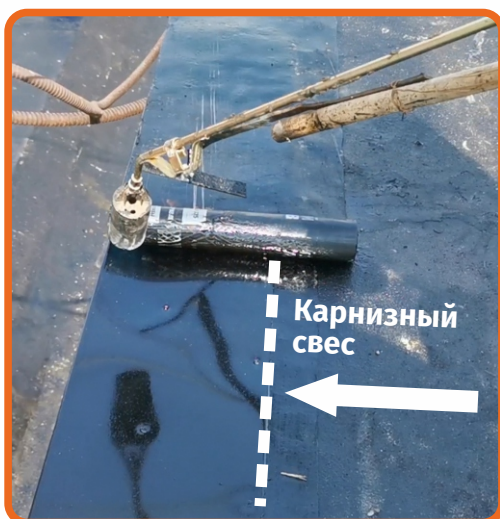
Дополнительный слой усиления на карнизном свесе, перекройте карнизный свес на 150 мм
