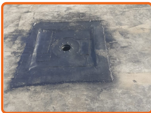
Водосточная воронка со слоем усиления 1000*1000 мм, уровень воронки понизить относительно основного уровня кровли на 20–30 мм в радиусе 500 мм
