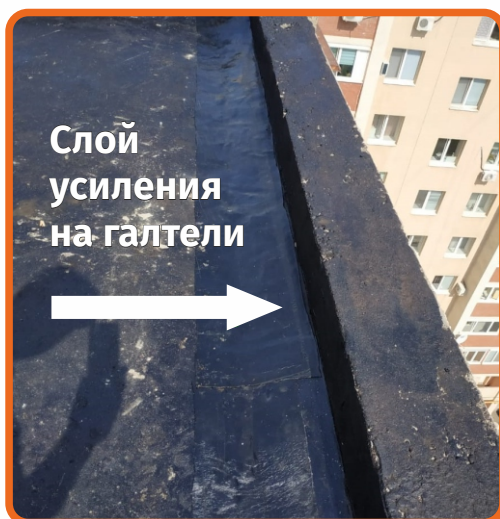
Дополнительный слой усиления на галтели
