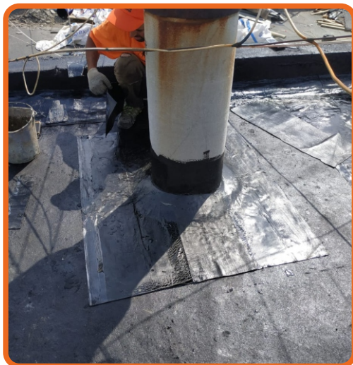
Дополнительный слой усиления на примыканиях к трубам
