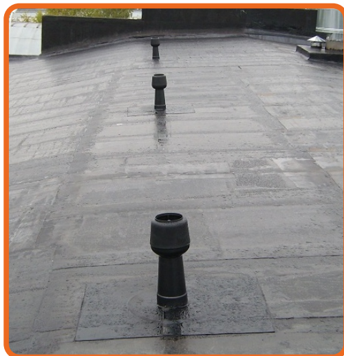
При выполнении ремонтных работ аэраторы необходимы для вывода скопившейся влаги в утеплителе и перекрытиях
